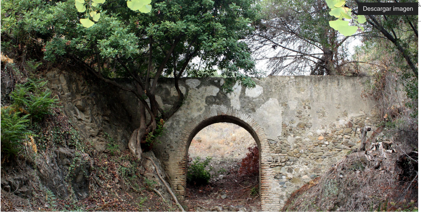
Vista del Acueducto
