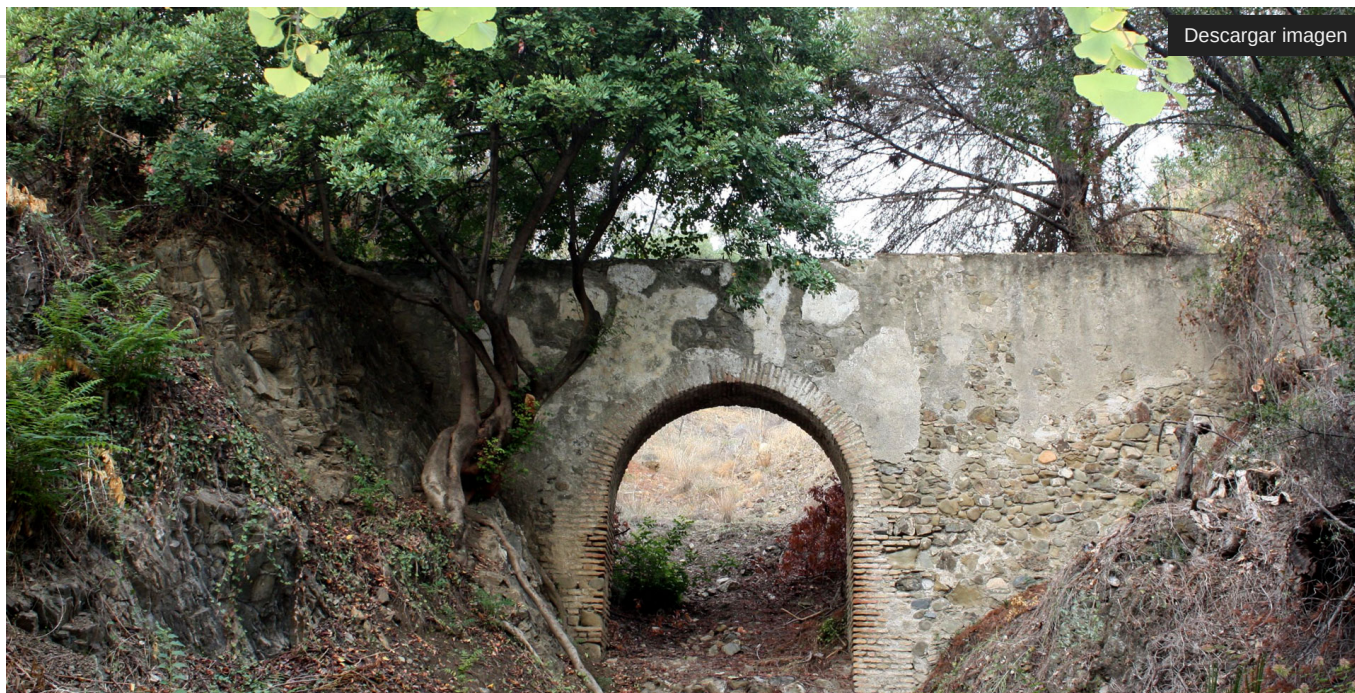
Vista del Acueducto
